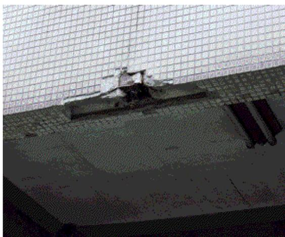
写真 1 外壁タイルの剥離
