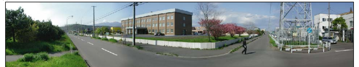
周辺写真：前面道路から見た既存庁舎
