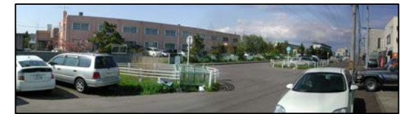
周辺写真：前面道路から見た既存庁舎
