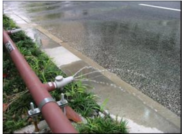
図-2 路面に散水される再生水 （東京都汐留土地地区画整理事業地区）
