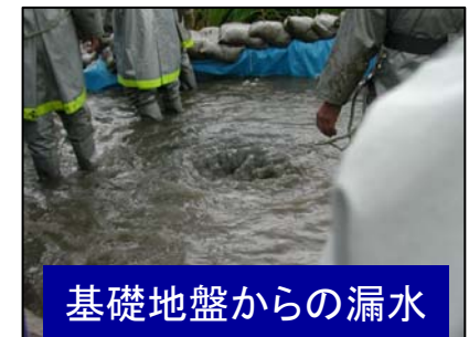
基礎地盤からの漏水
