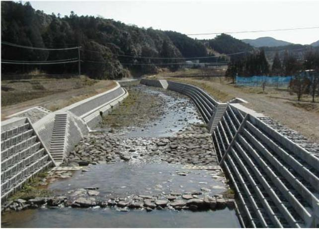
護岸の植生に配慮して環境保全型ブロックを用いているが、標準断面による画一的な工事が行われ、河床部や水際部には工夫が見られない。
