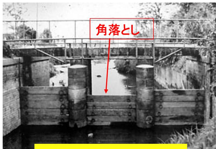
板状の「角落とし」を堰等にはめ込み取水量を調整。
