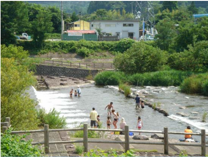
<馬見ヶ崎川 馬見ヶ崎河川公園 (山形県山形市大字釈迦堂地先)>
