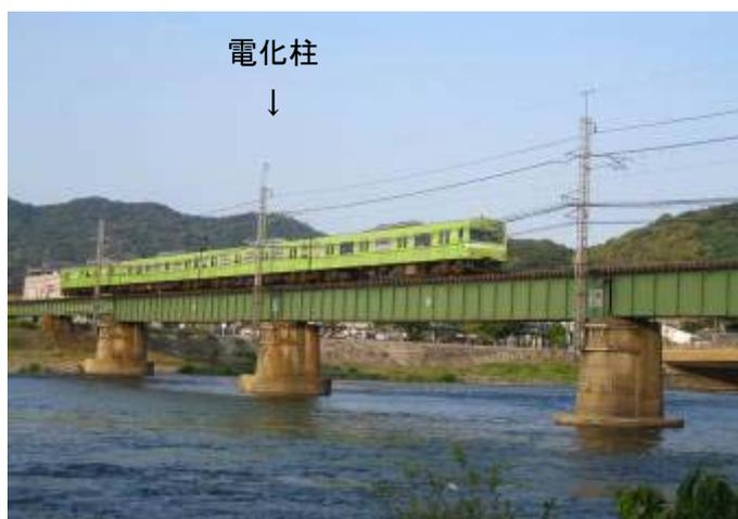
図-1 上路桁橋梁の例
