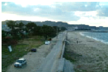
人の利用が多い海岸 事業実施箇所の状況 (松山港海岸【和気地区】)
