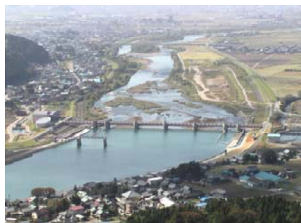
完成後の鳴鹿大堰付近の眺望
