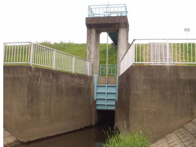
洪水時に閉めるべきゲート設備(水門・樋門等)
