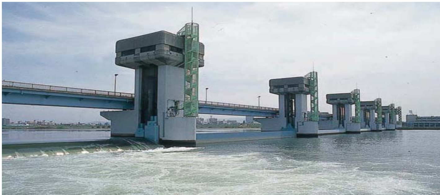
洪水時に開けるべきゲート設備(堰)
