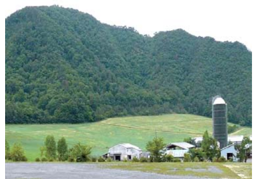
生産施設全景（施設の背景は牧草地）
