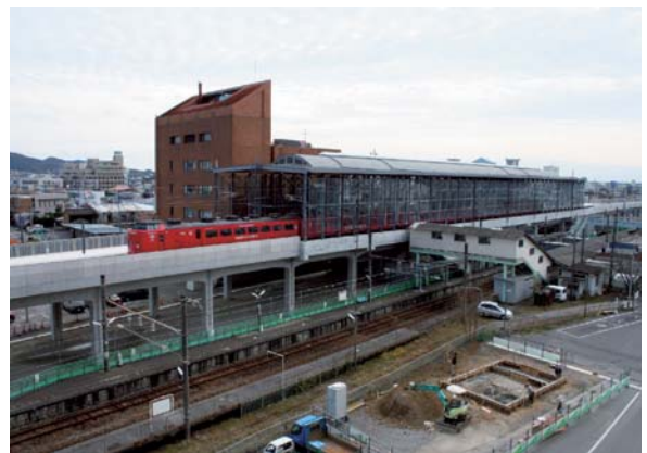
高架切替後の日向市駅（駅周辺の整備はH20まで）
