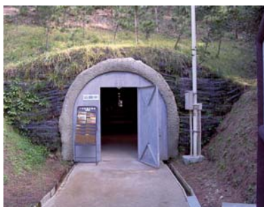
【トンネル通路入口】
