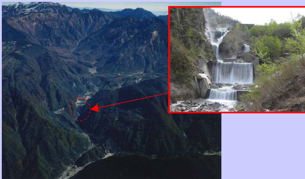
白岩砂防えん堤（立山砂防事務所）
