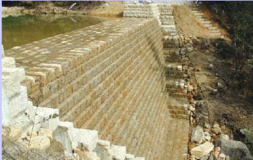
迎不動えん堤 (琵琶湖河川事務所)
