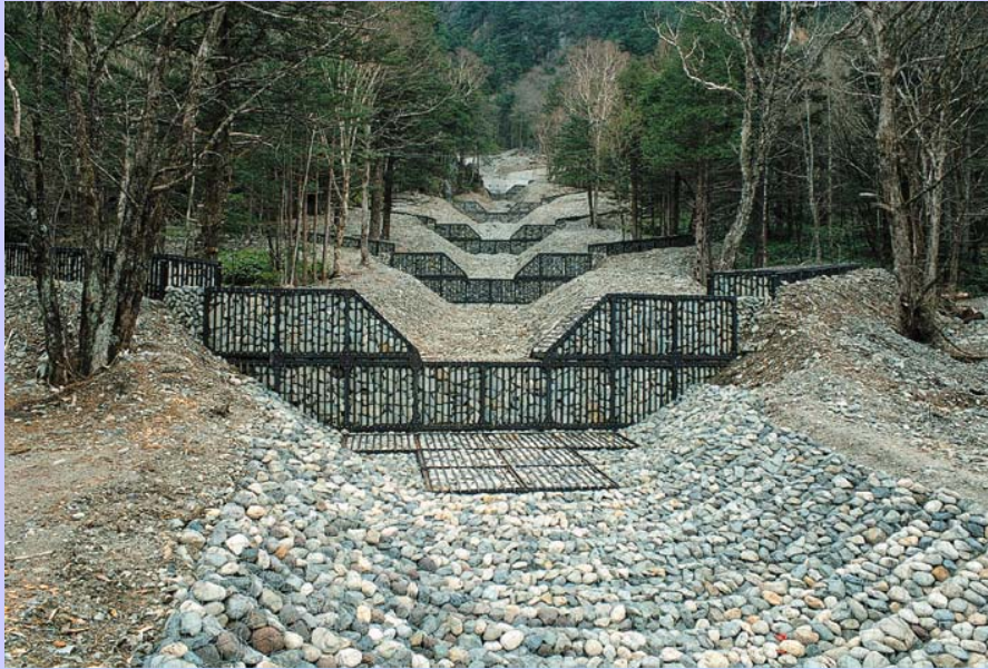
中千丈床固工（長野県）
