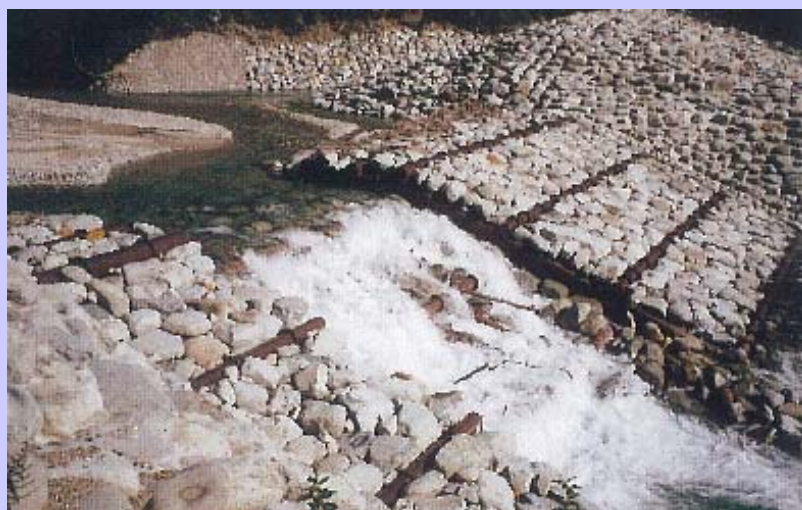
左俣谷床固工（神通水系砂防事務所）
