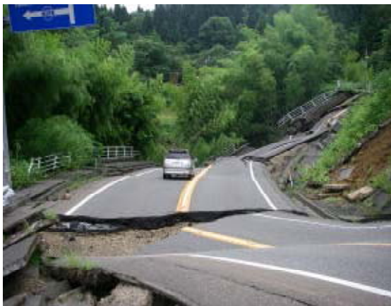
国道8号長岡市大積千本町
