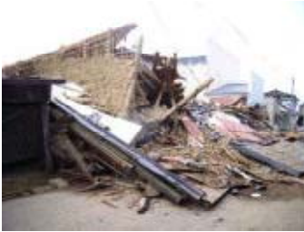
倒壊して道路交通を遮断した古い木造家屋
