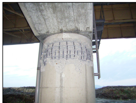
【新潟県中越地震により損傷した橋脚】
