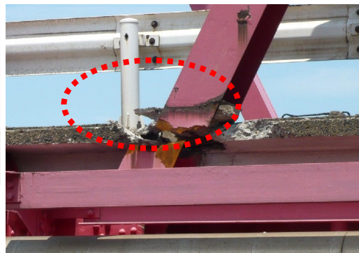
トラス橋の斜材の破断
