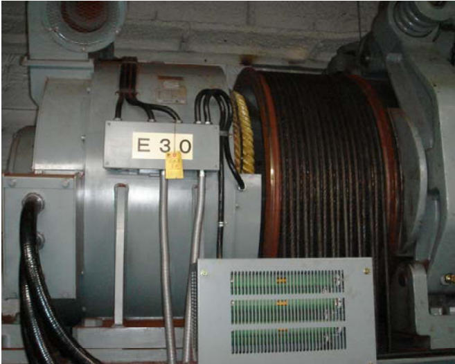
事故機 (E30号機) (シーブカバー外した状態)
