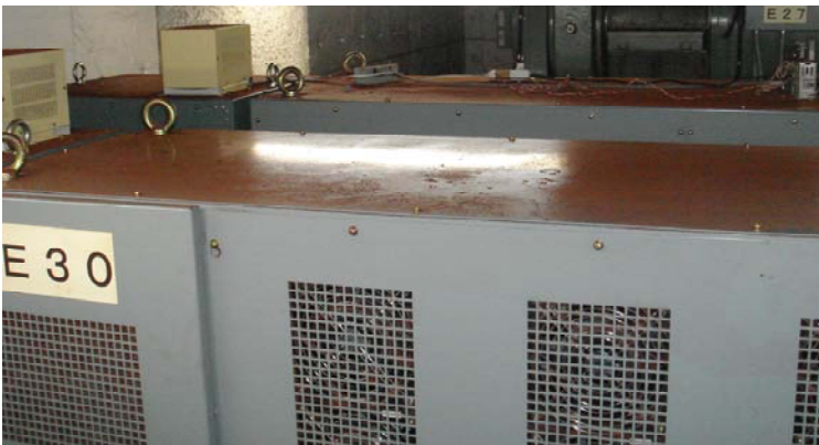
制御盤上面に飛散した赤錆粉
