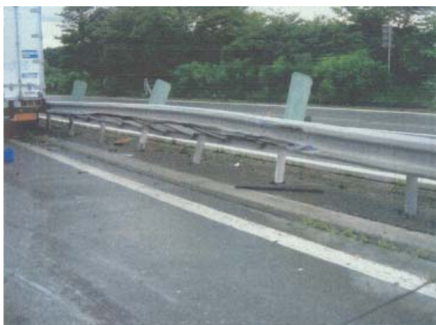
当該トラックが接触したガードレール
