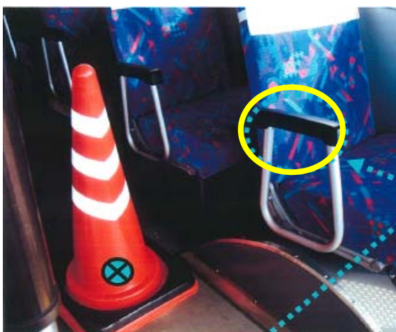
当該被害者が転倒した付近の手すり等の設置状況
