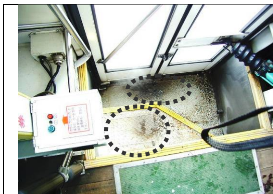
ステップ床面乾燥、凍結防止のヒーター (旭川電気軌道)
