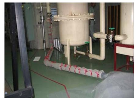
＜給水管を分岐し、仮設配管にて飲料水ブロックへ給水＞
