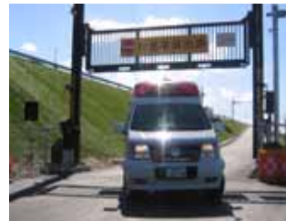
救急医療を支える高速道路の緊急出入口(青森市)
