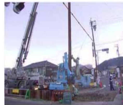
施工状況(引抜き)
