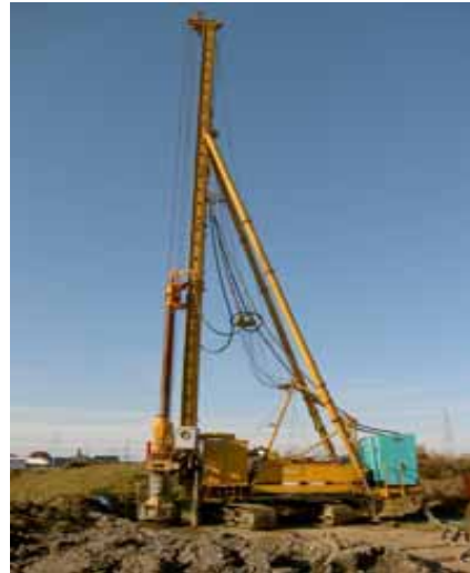
攪拌機(二軸)による打設状況
