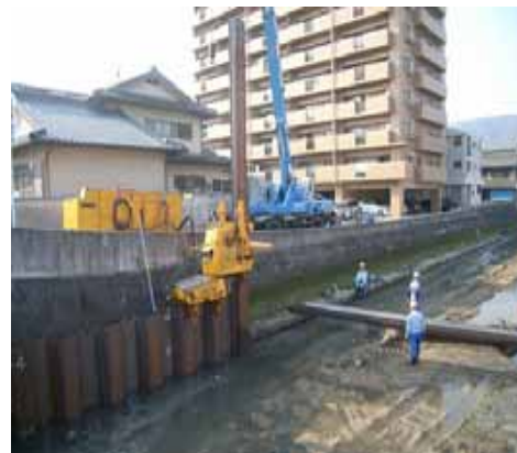
施工状況(圧入)
