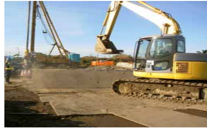
補助作業(敷鉄板移設)
