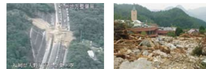
福岡県大野城市乙金(九州縦貫自動車道)被災状況
