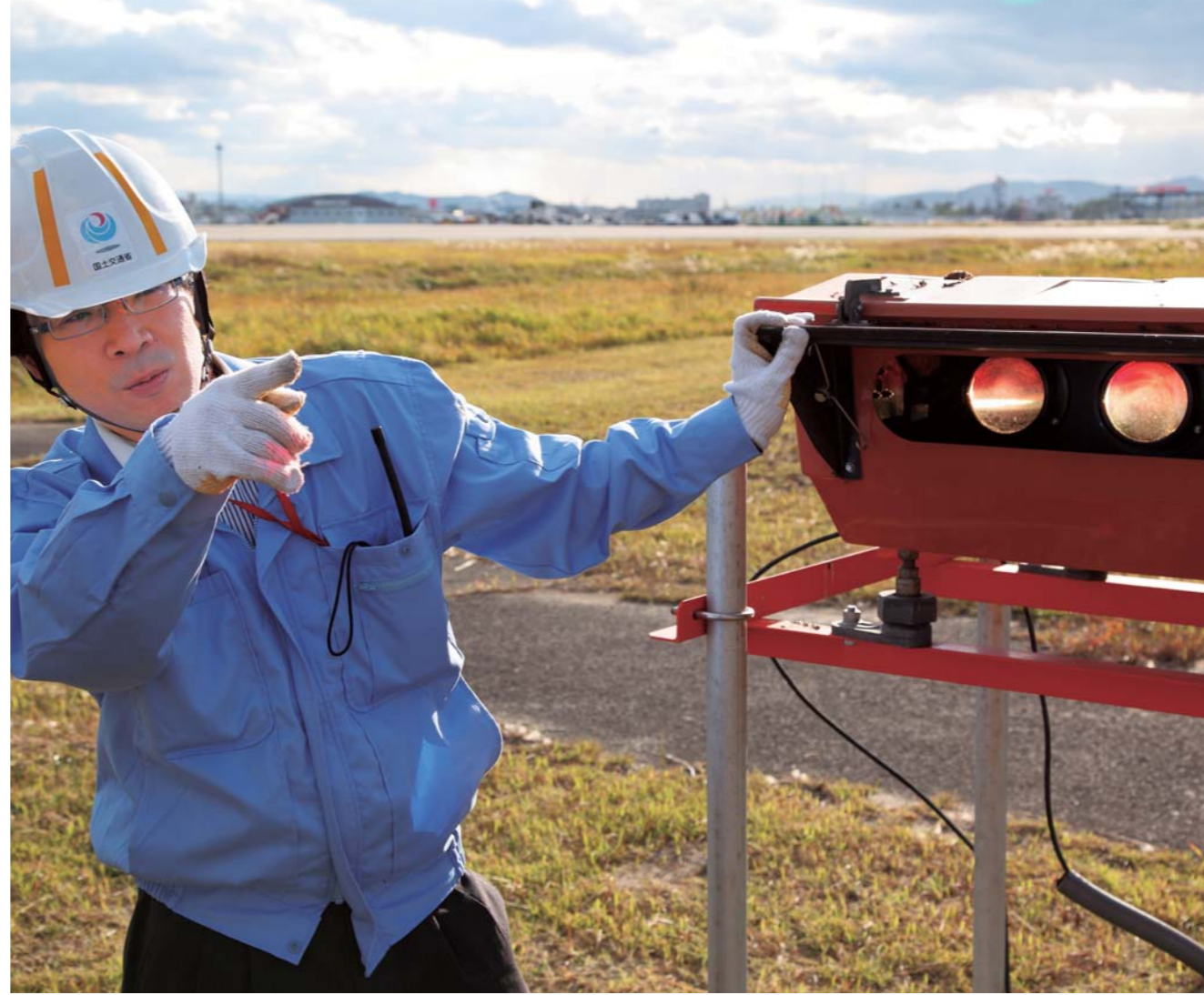
進入角指示灯 (PAPI) の角度をチェックする入江。台風時などはフードで中のライトを保護する。
