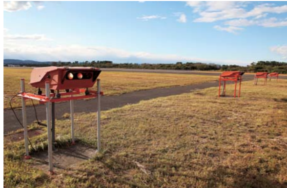
進入角指示灯は滑走路脇に4基設置。津波時には4基とも流失したが、4月中旬に復旧。
