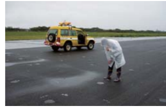
滑走路には鳥が落としたクルミなどが落下している場合もあり、吸い込むと機体にダメージを与える。日々の飛行場定時点検は欠かせない。
