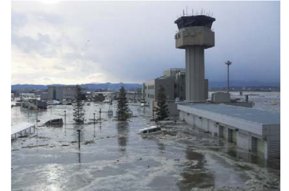
震災時、津波により冠水した仙台空港。手前の駐車場、右奥の滑走路とも水没した。
