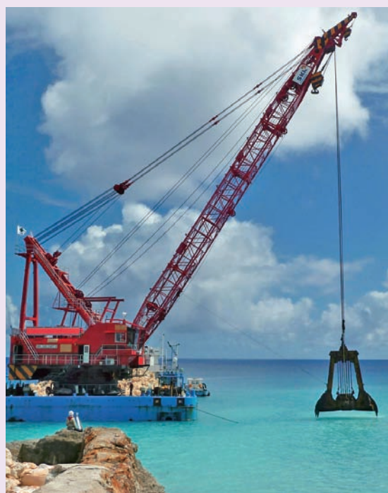
海底の浅い部分を掘る浚渫工事。
