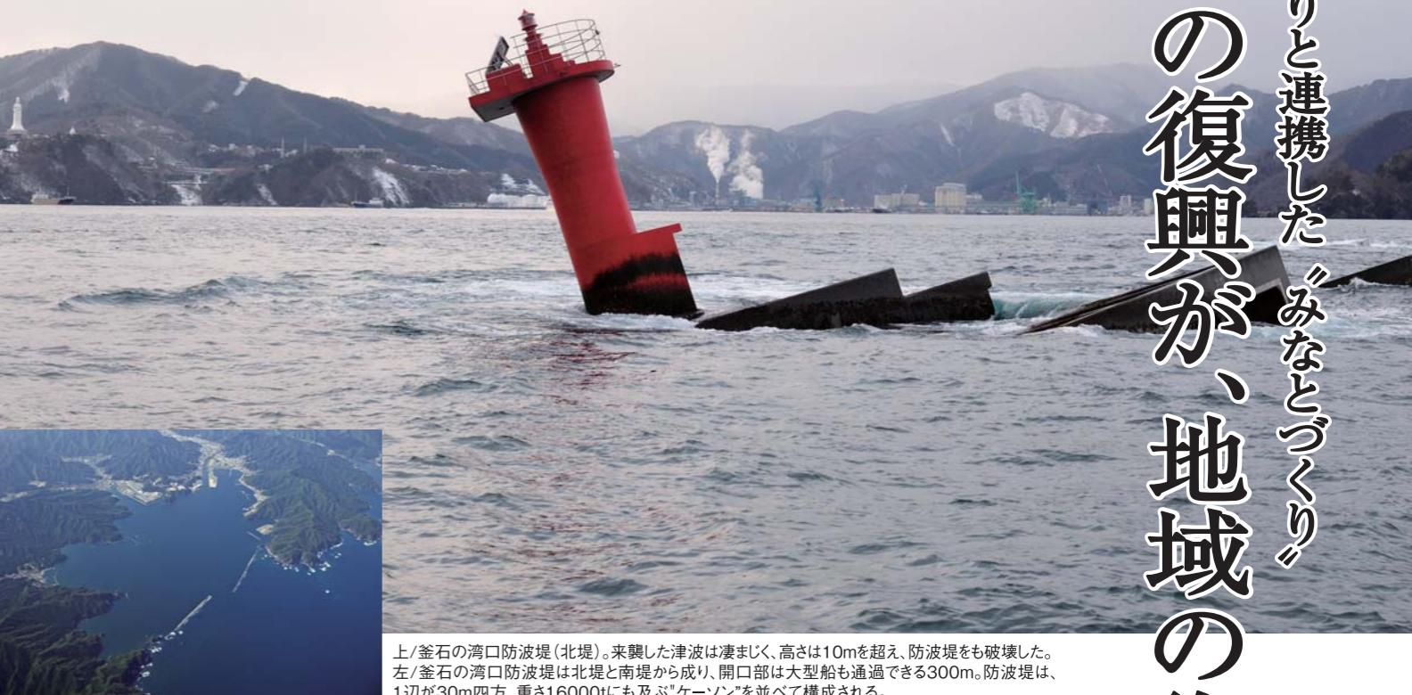
上/釜石の湾口防波堤(北堤)。来襲した津波は凄まじく、高さは10mを超え、防波堤をも破壊した。
