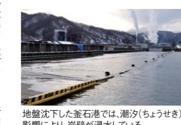
地盤沈下した釜石港では、潮汐(ちょうせき)の影響により、岸壁が浸水している。
