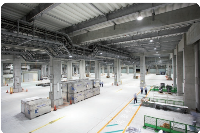
那覇空港の上屋内部。通関業務など輸出入に必要な工程をワンストップオペレーションで対応。
