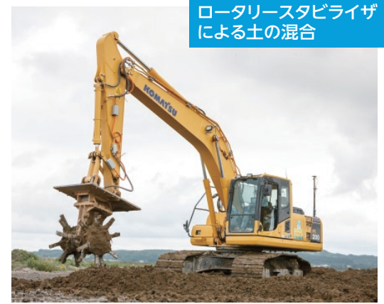
ロータリースタビライザによる土の混合 乾燥させた粘性土に砂質土を混ぜるロータリースタビライザ。広大な仮置き場で、地道な作業が続く。
