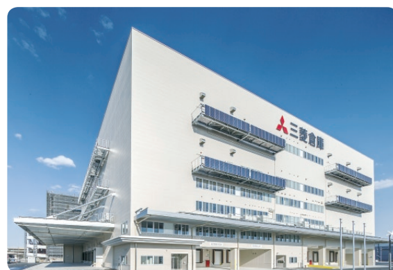
「災害に強いエコ倉庫」として設計された三郷2号配送センター。同社最新のノウハウが盛り込まれている。
