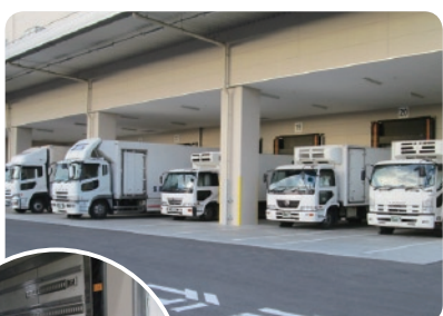
出荷に備えるトラック
