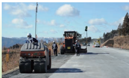
陸前高田ICから通岡IC間は、平成25年度の供用に向け舗装工事が始まっている。
