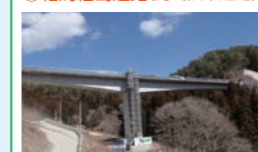
(仮)物倉橋施工現場
