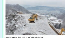
宮古市千徳地区の道路現場
