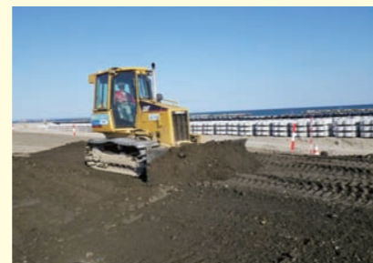
③改良土を敷きならす。その後タイヤローラーで固める。3~4m程度の高さまで盛る。
