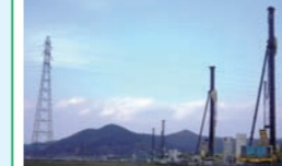
石巻市籠野地区の道路現場
