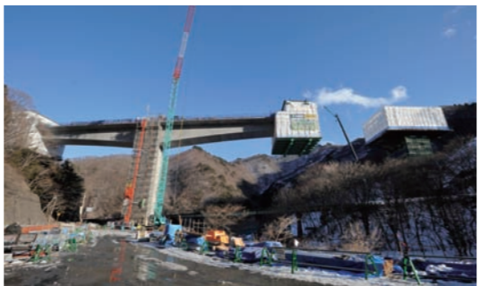
延長184mの(仮)水海(みずうみ)高架橋は、橋脚から左右1ブロックずつ、コンクリートを張り出していく工法で橋桁部分を施工。
