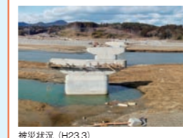
被災状況 (H23.3) 仮橋完成 (H23.6) 旧橋下部撤去中 (H25.2)
