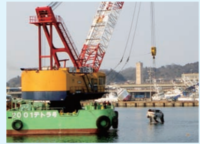
障害物撤去作業
