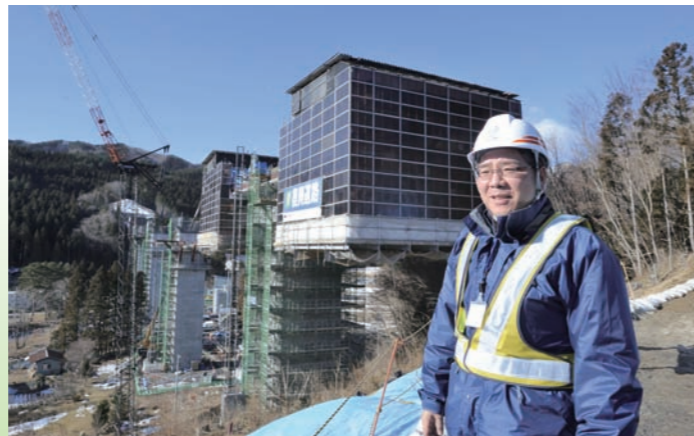
延長373mの(仮)吉浜高架橋。現在、上部工(橋桁部分)を施工中。橋脚から両側に1ブロック(約3m)ずつ張り出していく「張り出し架設工法」で施工。下を通る市道の交通規制が不要という利点がある。
