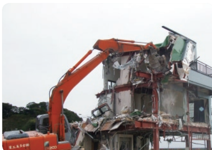
被害を受けた建物を解体。震災前は人が利用していたものを瓦礫として処理することにやりきれない思いも。
