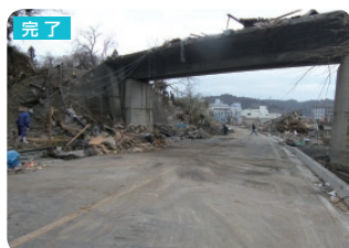
津波により橋脚から落ちた線路を切断しながら撤去。
