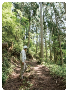
開設された森林作業道
