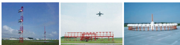
航法システム (電波で航空機を誘導)
