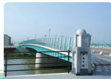
小松大橋…「都市計画道路根上小松線」街路事業で整備
