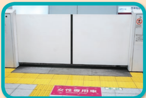
西早稲田駅はハーフハイトタイプのホームドアが整備され、転落事故や接触事故を防いでいます
