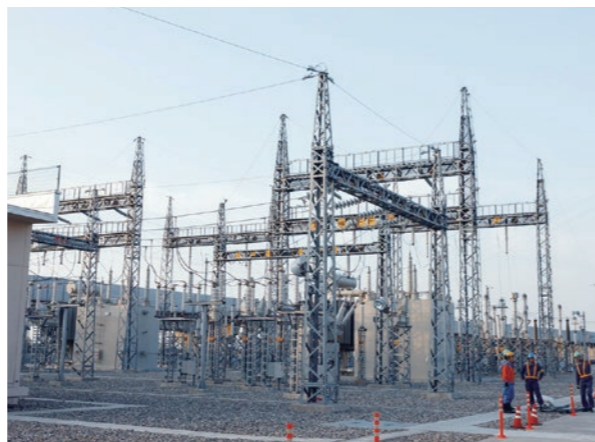
検査が実施された新白山変電所
