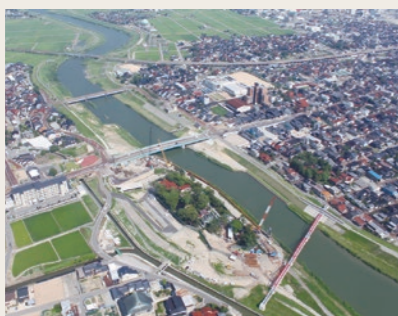
分水路改修事業
