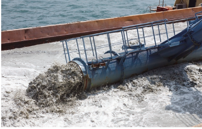
土運船の船倉に吐き出される海水と土砂。船倉には仕切り壁を設け、浚渫土を堆積させ余剰水を還流ポンプで吸入。吸入された水はカッタードリルが掘削する海底にと流れていく
