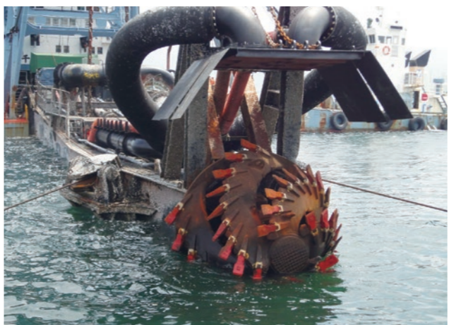
海底地盤を掘削するカッターヘッド。ここで採用されている方式は海水の濁りを抑える方法の一つ
