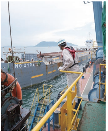
土運船がいっぱいになると、海上で待機していた次の土運船がすぐに横付けされる
