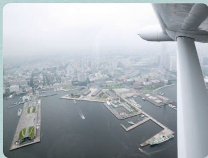
上空300mから見た横浜港大さん橋国際客船ターミナル付近(広報課撮影)
