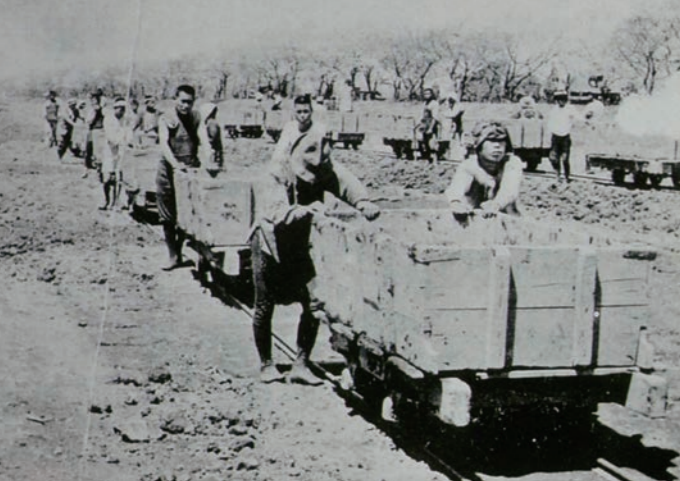
荒川放水路をつくるため、掘った土をトロツコで運ぶ人々。工事は工程によって蒸気機関車や蒸気船なども使われたが、現在と比べると人力の作業の比率が大きかった。この工事で掘った土は2180万m 3 （東京ドーム18杯分）にも及んだ。
