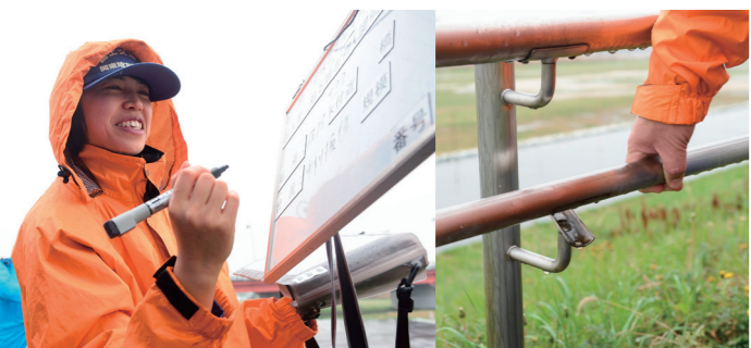
手すりの留め具の破損を発見。後日の修繕が必要のため、記録写真で掲示するボードに位置、状況などを詳細に記録。この点検は、ゴールデンウィーク前と学校が夏休みに入る前に実施する。
