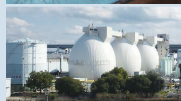
メタン発酵槽の中では気泡状のバイオガスが発生している。
