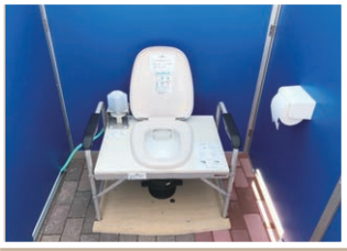
マンホールトイレの内部（写真は北九州市で用意されているもの）
