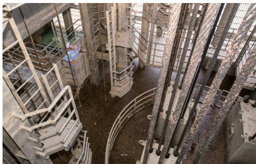
選択取水設備の内部を点検。通常時はこの設備から取り込んだ水が放流管を通じて下流に流されている。
