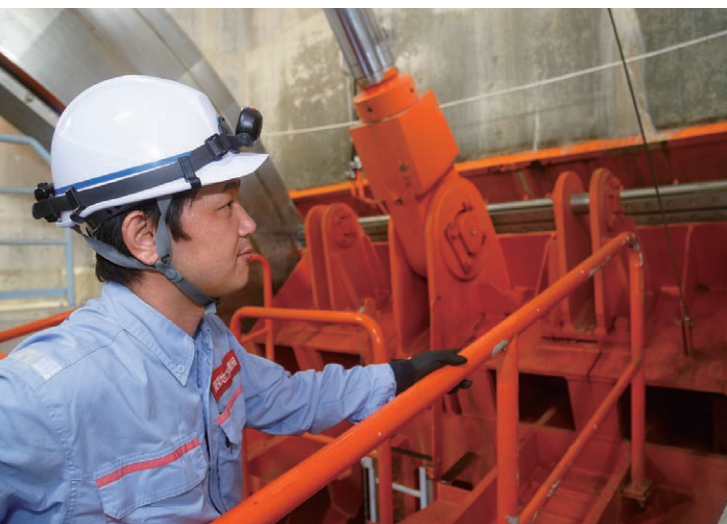
ダム下部にある低位常用洪水吐（水を放流するところ）のゲートの状態を確認する濱中。
