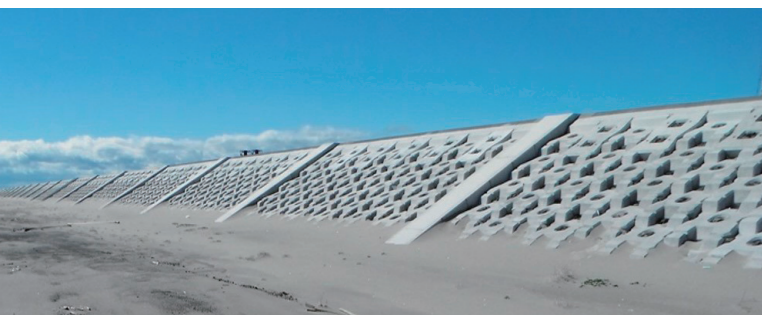
多重防御の第一線である完成した海岸堤防(仙台湾海岸/深沼地区)。巨大津波が越流しても粘り強く効果を発揮する構造となっている。
