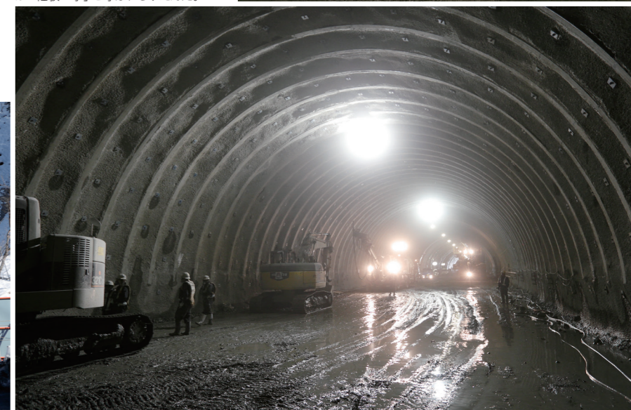
庄司が担当するトンネル工事の現場。基本的には火薬で岩を砕き、土砂を運び出してトンネルを掘り進める。岩の硬さや亀裂の状態によって適切な火薬の量や間隔を調整するが、その判断は難しい。トンネル工事が「経験工学」と呼ばれるゆえんだ。
