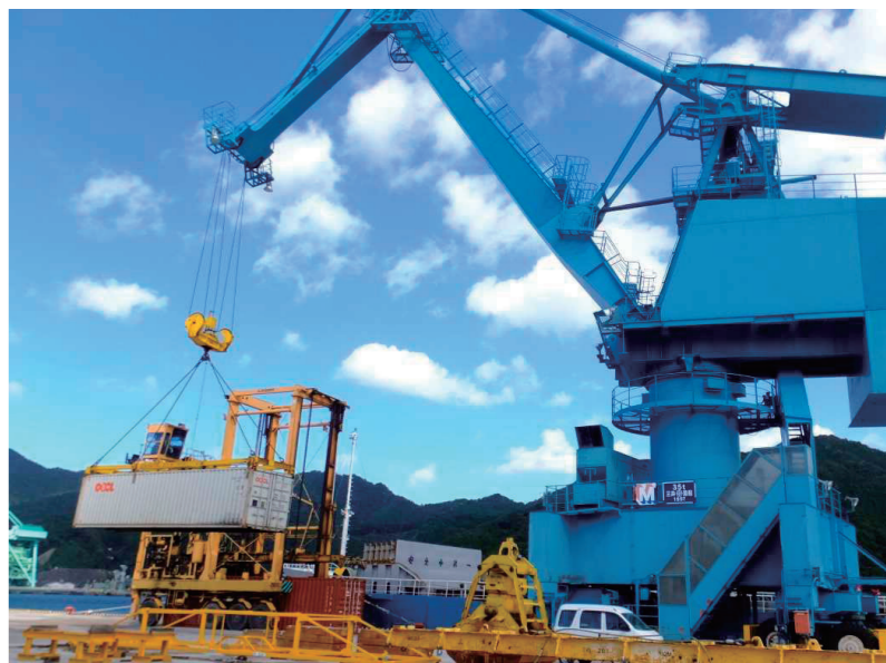
岩手県釜石港では、港湾と道路の整備により、平成27年のコンテナ取扱量が県内の過去最高記録を更新した。
