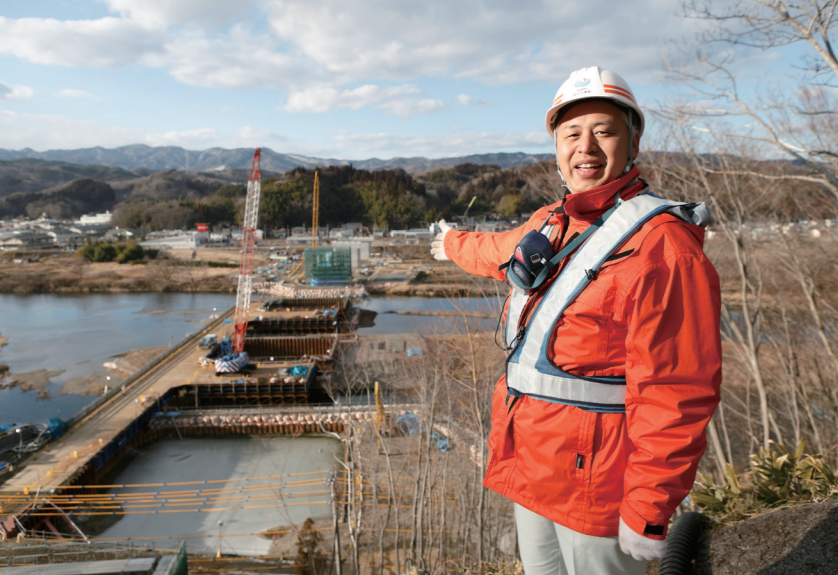
閉伊川に架かる橋梁の工事現場。この橋梁は三陸沿岸道路の一部である「宮古老道路」の橋で、河川・道路・鉄道を越え、丘陵部を切り開いて整備する道路とつなげていく。工事を一望できるこの高台は庄司のお気に入りのスポットだ。
