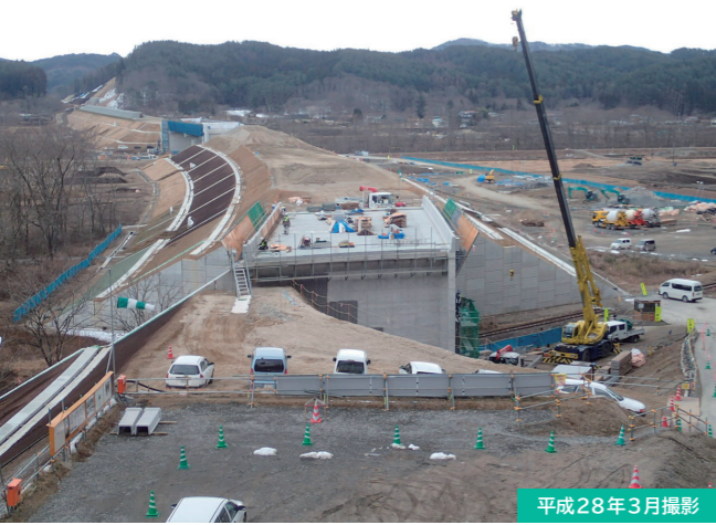
山田宮古道路の工事現場の変遷。住民の生活エリアも通過するため、付近の景観は劇的に変化する。写真の現場では丘陵を切り開き、その土砂を盛土しながら平野部を整備している。
