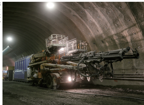
ドリルジャンボは、火薬を仕掛けるための孔を岩盤に開ける重機。火薬を仕掛ける足場としても活躍する。
