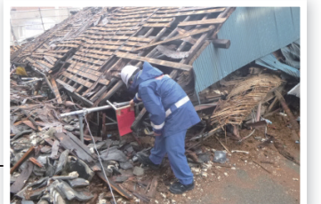
建築物の応急危険度判定の様子
