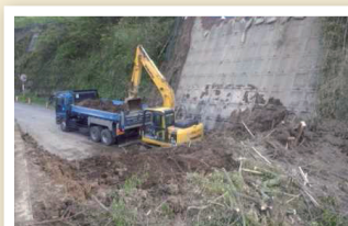
道路啓開状況
