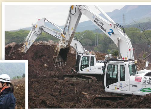
無人バックホウで土砂撤去を実施(南阿蘇村)
