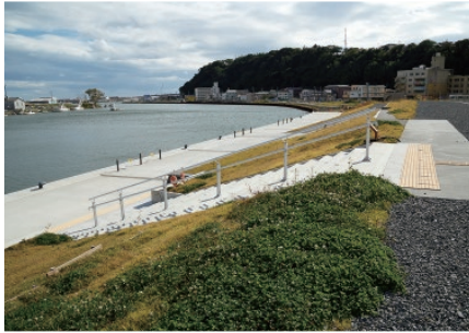
本年1月に完成した右岸中央地区の堤防。石積みの高さは座りやすい高さにするなど検討されている。石積みや舗装のアフセントには地元の井内石を使用。
