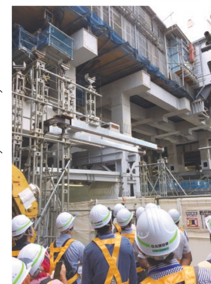
銀座線渋谷駅の改良工事現場
