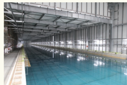
新設中の試験水槽(曳航水槽)
