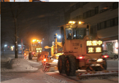
機械も人も昼夜の区別なく出動する。降りしきる雪の中、除雪作業は続く。
