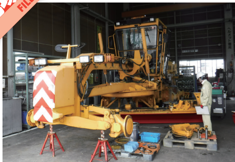
夏に行う除雪車の分解整備
