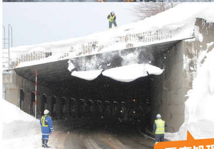
道路標識(写真上)やスノーシェッド入口部(写真下)に積もった雪の人力による処理
