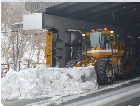
スノーシェッド内に吹き込んだ大量の雪を処理
