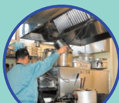
換気設備の風量測定
