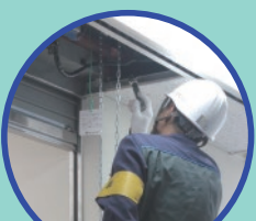
防火設備の駆動装置検査
