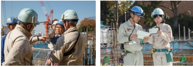
タブレットの活用で最新の設計データなども即時に共有。現場での確認もスムーズになる。
