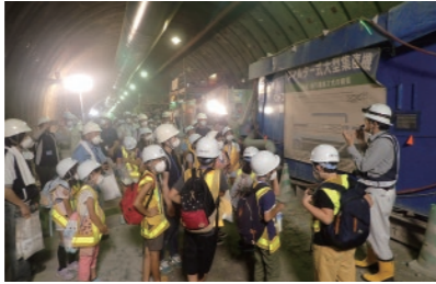
トンネル工事で使う機械の説明
