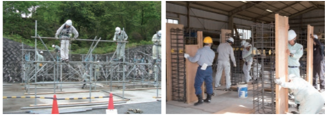
(左から) 足場組立の訓練 (建設労働者緊急育成支援事業)、柱の型枠建込の訓練 (実務施工体験研修)
