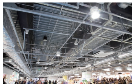
天井に化粧ボードを貼らず、はりや配管がむき出しとなっている第3ターミナル
