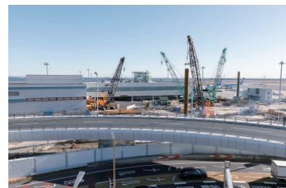
第2ターミナル南側の増改築工事の様子
