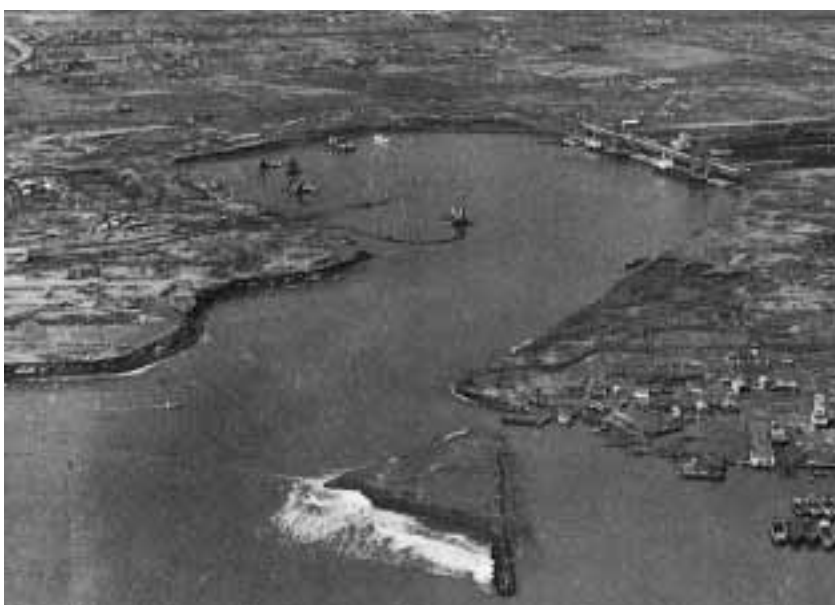
苫小牧臨海工業地帯造成計画によって進められる苫小牧港の浚渫整備(昭和38年)
