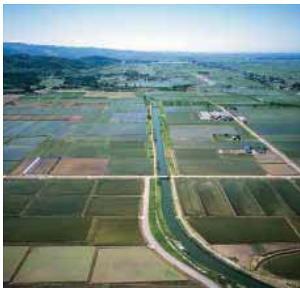
約27,000haの農地に農業用水を供給する北海幹線用水路（美唄市）
