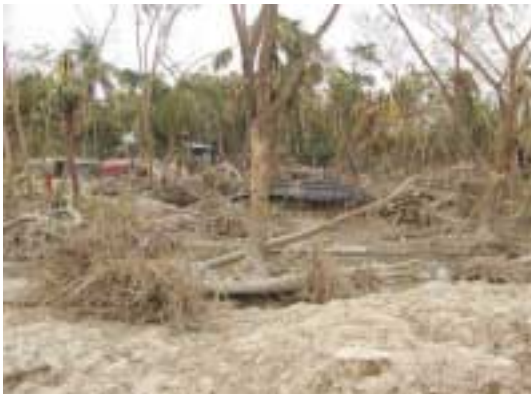
写真5 強風と高潮で被災した集落
