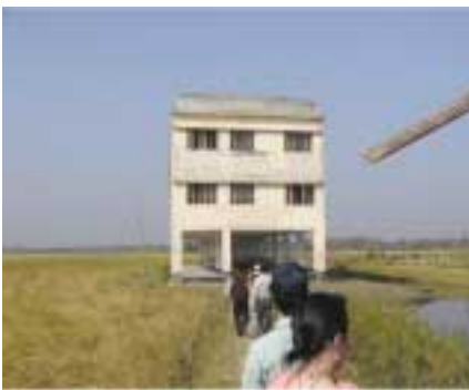
写真1 学校にも活用されているサイクロンシェルター
