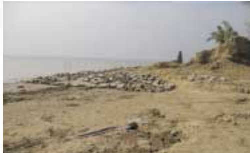
写真3 堤防が流された地点
