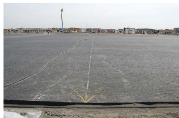
写真-6 浸透固化改良部の舗装面状況
