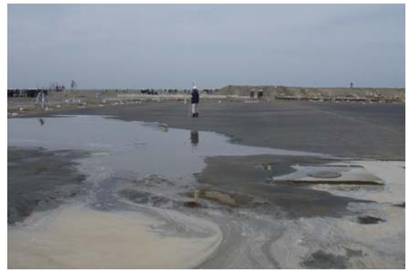
写真-4 未改良部の浸水状況
