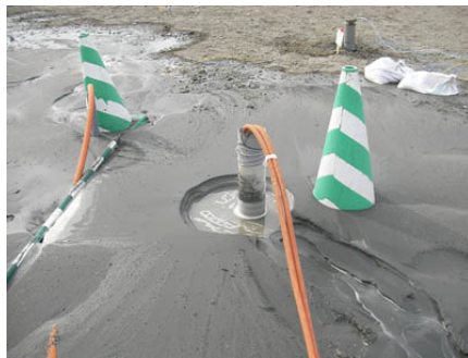
写真-1 無改良部（無対策範囲）水圧計位置 発破直後の状況
