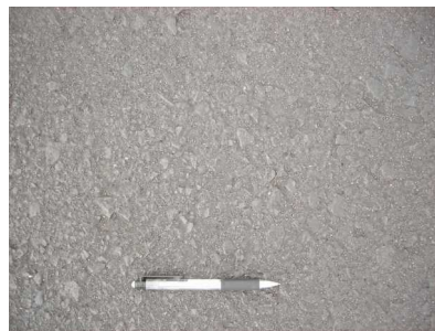
写真 - 6 施工後(アップ)
