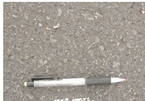
写真 - 2 良好状態(2工区,12ヶ月後)
