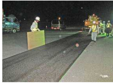
写真 - 4 本施工状況
