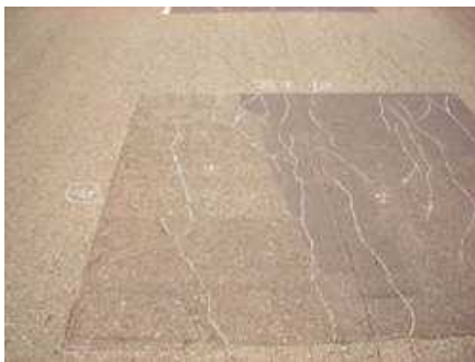
写真 - 1 摩耗状態(4工区,7ヶ月後)
