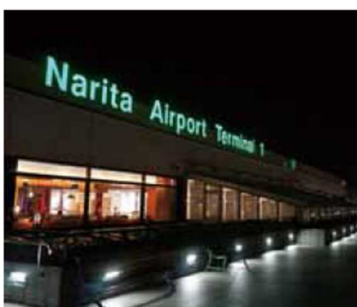
第1旅客ターミナルビル館外LEDサイン
