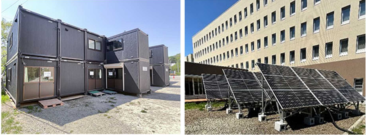
図 4.2.3 仮設現場事務所・太陽電池パネル 出典：五洋建設株式会社 HP
