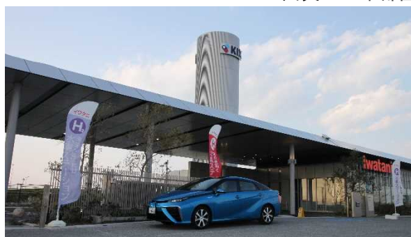
写真 5.2.5 イワタニ水素ステーション関西国際空港 (オフサイト方式)
