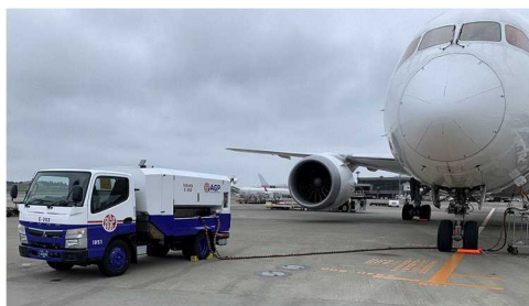
写真 5.1.1 移動式 GPU(自走・発電方式)
