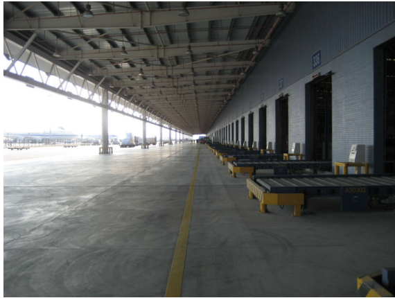
エプロン側、ここから航空機に搭載する
