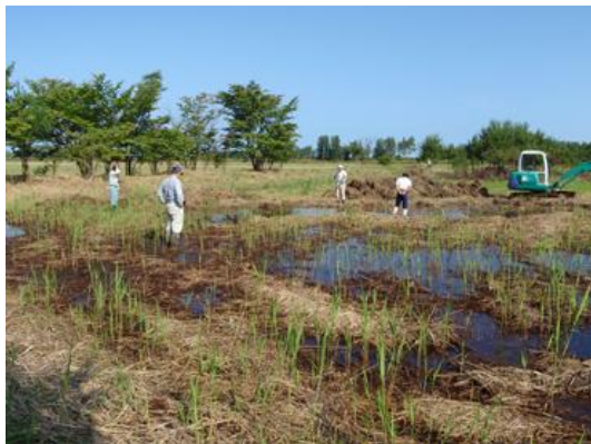
【所有する機械を持ち込みビオトープを造成】
