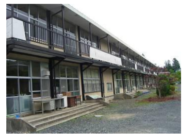
【谷内小学校の現校舎】
